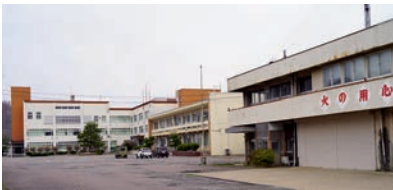
旧庁舎・中央公民館・旧消防のようす
