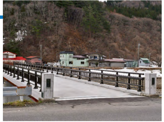
通行止めが解除された開晴橋
