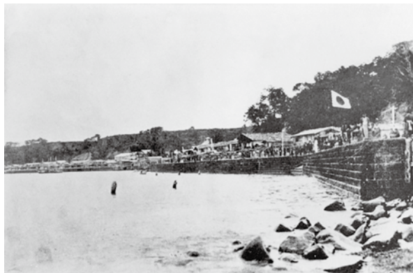
本町の石垣護岸工事竣工（明治36年） 大量の石材は十面沢（弘前市）から切り出され運搬された
