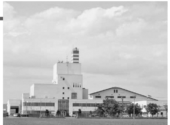
黒石地区清掃施設組合（同組合HPより）
