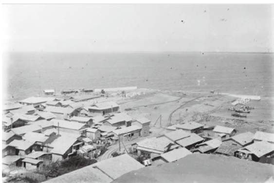
築港工事中の弁天崎(昭和10年頃)天童山から撮影 埋立地まで土砂を運んだトロッコの軌道が写っている
