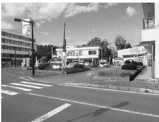
整備前の駅前広場
