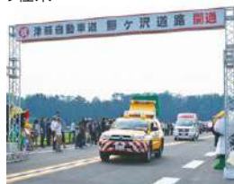
津軽自動車道の完成
