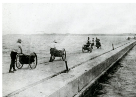
土砂の運搬の様子
