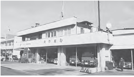
築45年で老朽化が進む消防署
