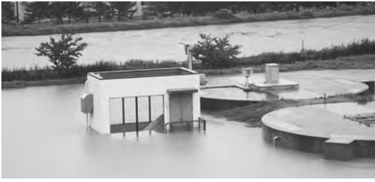
台風18号の大雨により浸水した汚泥ポンプ室
