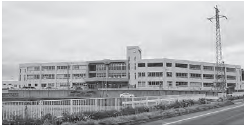
舞戸小学校は、屋上に太陽光パネルが設置されます
