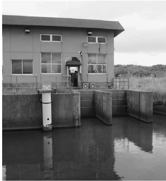
排水ポンプが設置されている川尻排水機場
