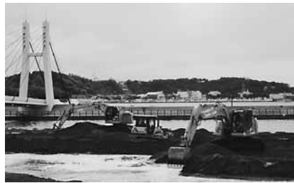
堆積した土砂を撤去する重機 (6月21日)
