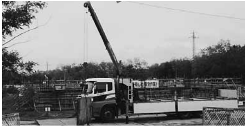
新消防庁舎の建設現場（6月14日時点）
