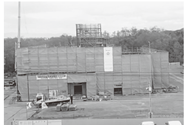
消防署建設現場 (10月21日時点)
