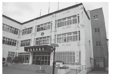
老朽化した町役場
