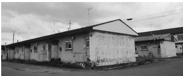
昭和50年代に建設された大鳴戸団地
