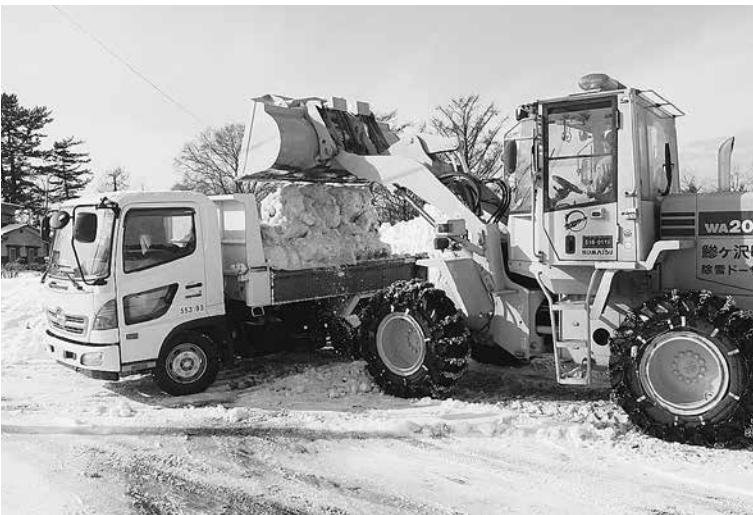
排雪作業中の堆雪現場
