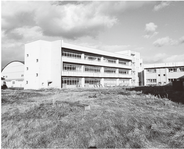
新庁舎建設予定地 (旧鱒ヶ沢第一中学校グラウンド、写真中央が北棟校舎)
