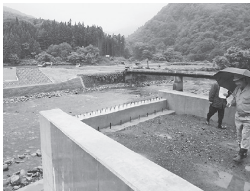
橋台の上から現場を確認 (橋の架設は12月完成予定)
