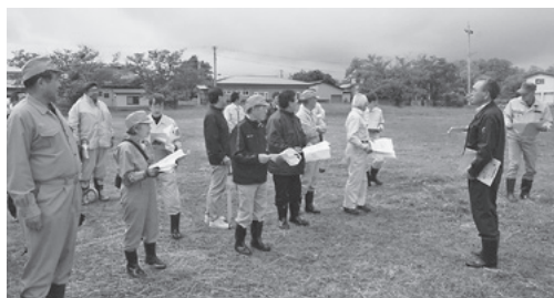
グラウンド跡地内で庁舎建設配置を確認
