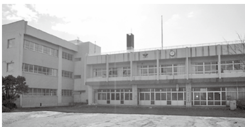
解体が決定された旧鰻一中校舎
