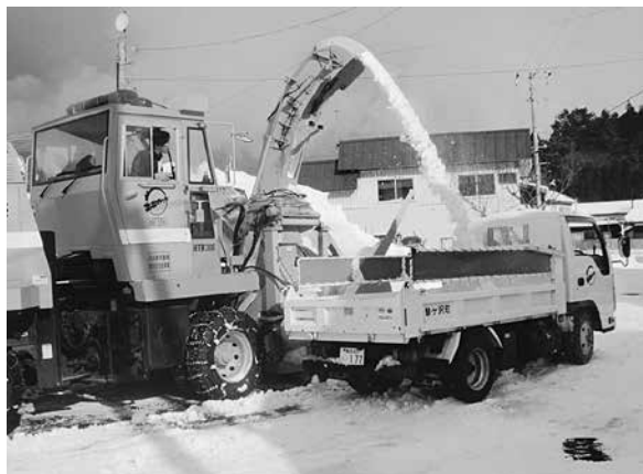
除排雪作業の様子
