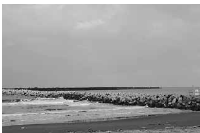
延伸工事が完成した南防波堤
