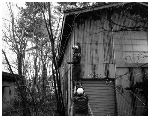
強風等により空き家の応急対応に追われる消防署員
