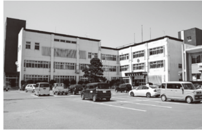
新庁舎へ移転する町役場
