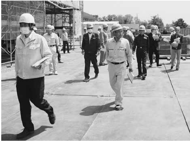
新庁舎建設現場前
