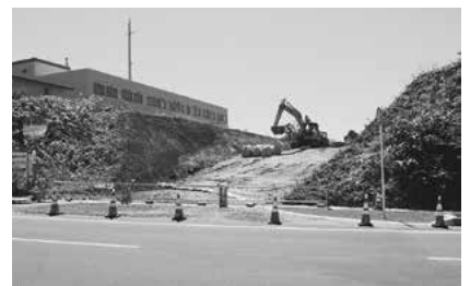
国道101号バイパス側からの工事現場
