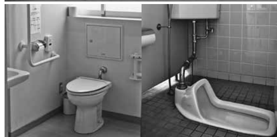
中央公民館の多目的トイレ(左)と和式トイレ(右)
