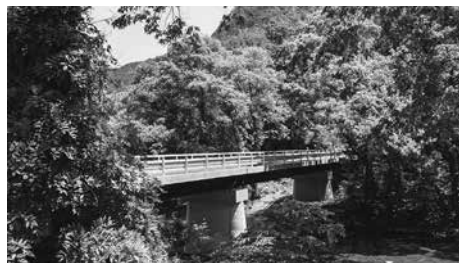
改修工事を終えた赤沢橋
