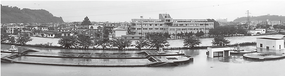
8月9日、浄化センター付近のようす
