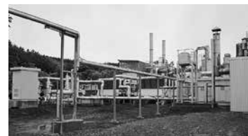
④温水は熱導管で、蒸気は供給管で施設内へ
