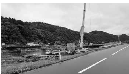
復旧工事が進む開晴橋
