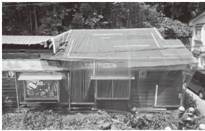
緊急安全措置が行われた空き家
