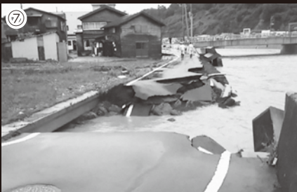
①水位が上昇した中村川 (舞戸橋、9日15時30分頃) / ②奥へ続く道路は浸水して見えず (岩谷、9日15時30分頃) / ③冠水した田んぼとビニールハウス (中村、9日15時30分頃) / ④水に飲み込まれた駅前広場 (舞戸、9日) / ⑤浸水した町浄化センター (蒲生、9日17時頃) / ⑥アユ養殖施設では約28,000尾のアユ成魚が流出・へい死した (大然) / ⑦中村川護岸の決壊 (新田町) / ⑧折れ曲がった鉄道橋 (舞戸) / ⑨寸断された赤石溪流線 (大然) / ⑩仮置き場の災害ごみは4000tを超えた (旧大高山スキー場駐車場)
