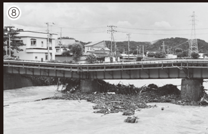
①水位が上昇した中村川 (舞戸橋、9日15時30分頃) / ②奥へ続く道路は浸水して見えず (岩谷、9日15時30分頃) / ③冠水した田んぼとビニールハウス (中村、9日15時30分頃) / ④水に飲み込まれた駅前広場 (舞戸、9日) / ⑤浸水した町浄化センター (蒲生、9日17時頃) / ⑥アユ養殖施設では約28,000尾のアユ成魚が流出・へい死した (大然) / ⑦中村川護岸の決壊 (新田町) / ⑧折れ曲がった鉄道橋 (舞戸) / ⑨寸断された赤石溪流線 (大然) / ⑩仮置き場の災害ごみは4000tを超えた (旧大高山スキー場駐車場)
