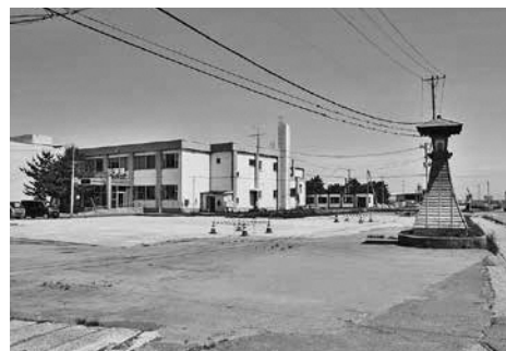
旧消防署跡地工事終了後のようす
