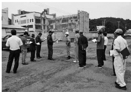
旧役場庁舎解体のようす
