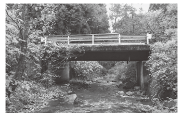
改良される林道長間瀬線1号橋
