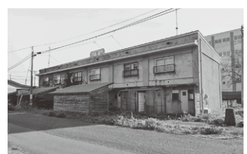
解体予定の旧医師住宅
