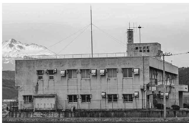
供用開始以来40年が経過している町浄水場
