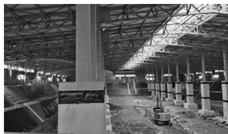
廃棄物埋立地に散水するようす
