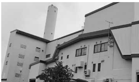
西部クリーンセンター外観
