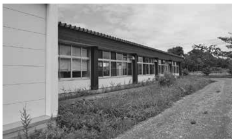
鯉ヶ沢中学校第二体育館付帯施設の外觀
