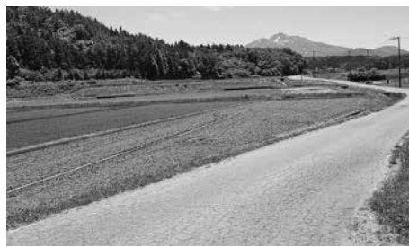
舞戸中村線道路改良工事現場
