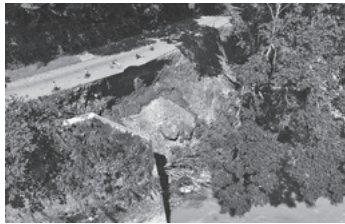
災害復旧が行われる赤石溪流線
