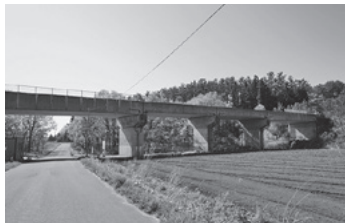
改修されている茂平橋のようす
