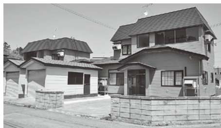
改修された新田地区の多目的住宅
