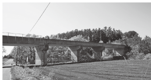
補修される茂平橋
