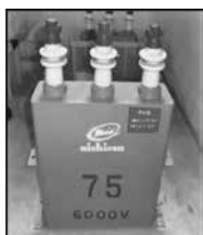
電力用 コンデンサー
